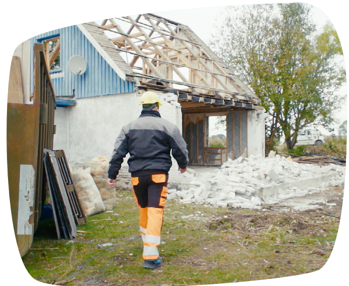
Selektiv nedrivning i Slagelse Kommune
