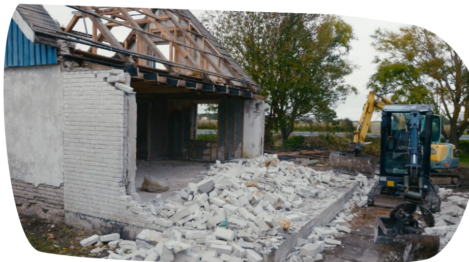
Selektiv nedrivning i Slagelse Kommune
