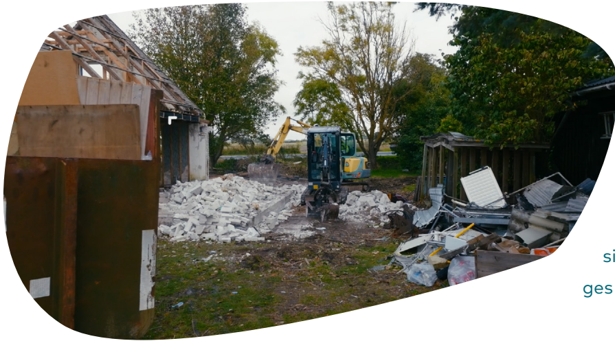
Selektiv nedrivning i Slagelse
