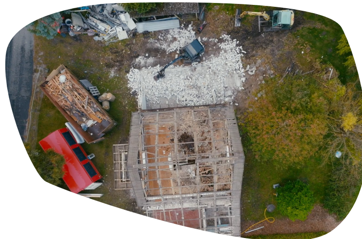
Nedrivning i Slagelse Kommune
