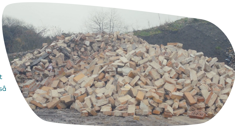
Selektiv nedrivning i Slagelse
