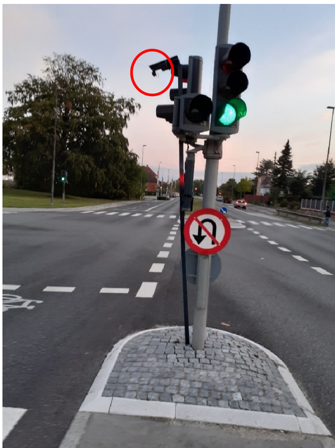
Figur 5: Montering af kamera til registrering af køretøjer fra Linde Allé.
