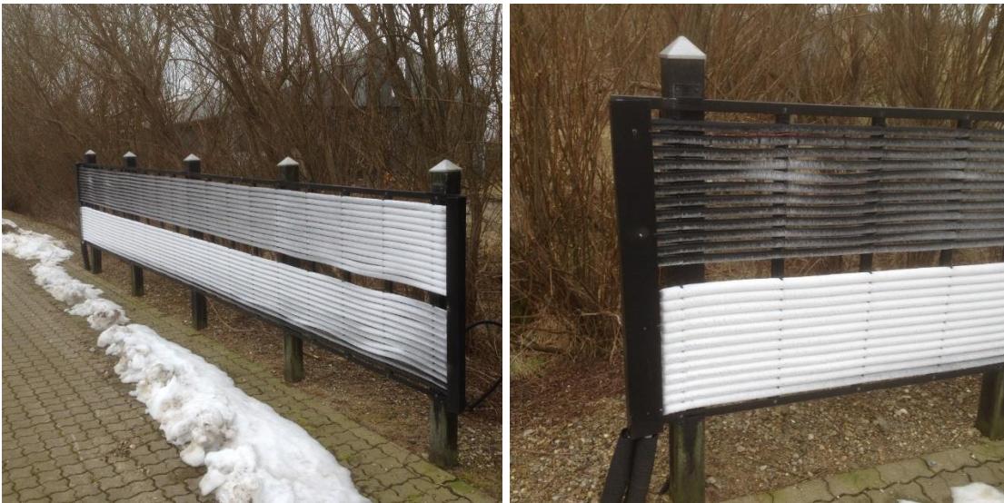
Figur 3: Billeder af en energifanger fra en vinterdag. Den kolde brine fra varmepumpen kommer op i fangeren i nederste venstre hjørne og vender i den højre ende. Undervejs kan man se at den opvarmes af luften. Se også beskrivelsen i bilaget.
