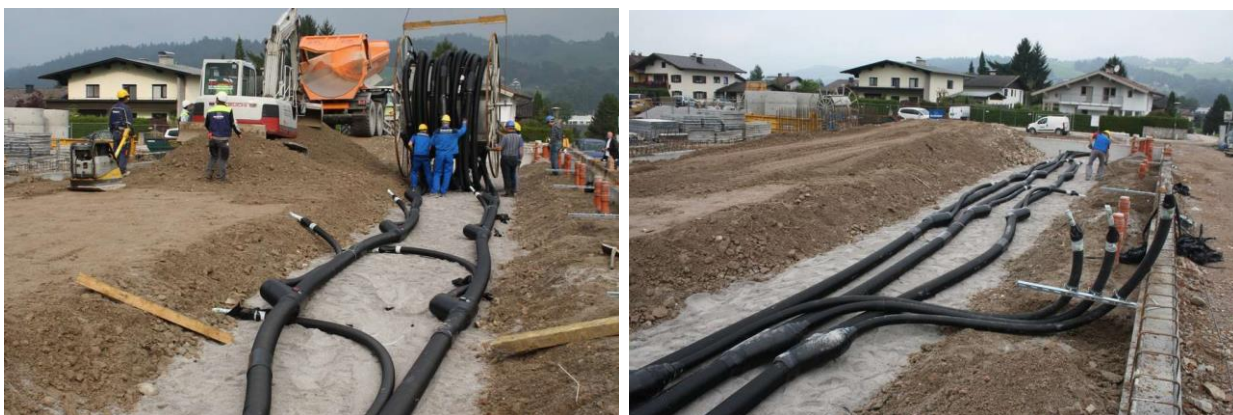
Billede: Montage af gadeledninger med stikledninger – enkelt og hurtigt.
