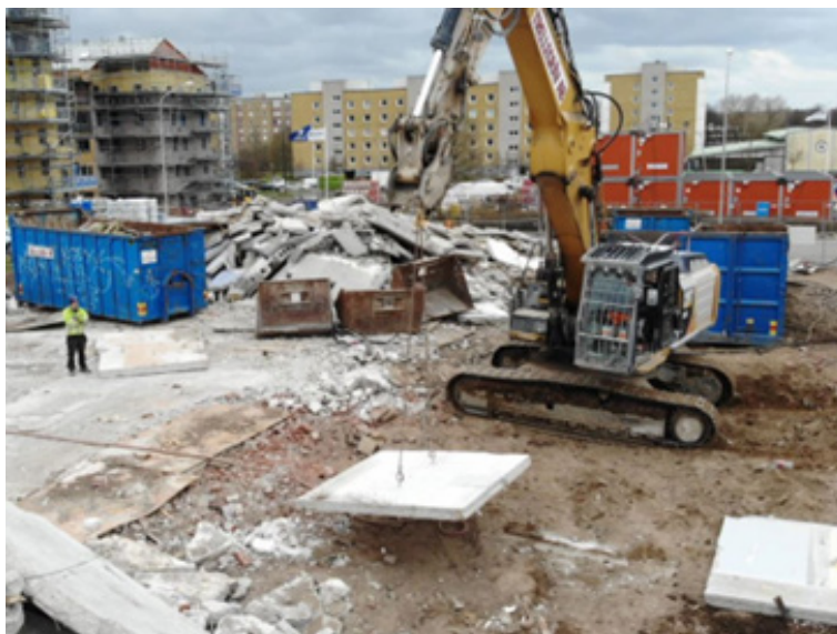
Foto: betonelement på Drottninghög
