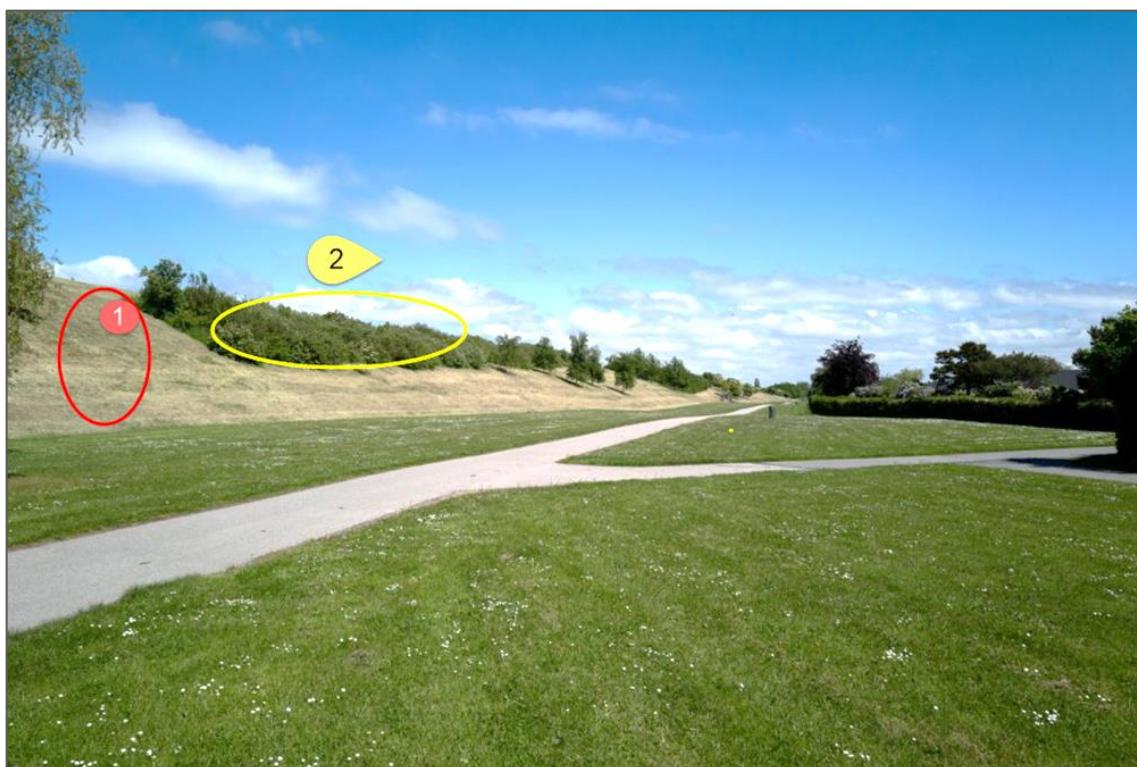
Figur 8 En støjvold med buske og langt græs – område 2 – er mere effektiv end en støjvold med kort græs som i område 1.
