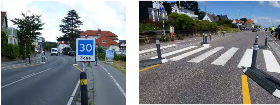
Figur 8 Eksempel på midlertidige indsnævring på Strandvejen i Espergærde, Helsingør Kommune
