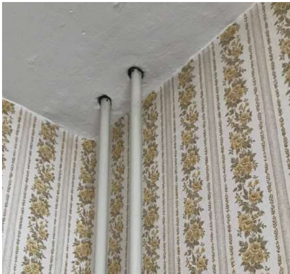
Venstre: Utætheder ved varmerør i lejlighed. Højre: Lydmålinger af lydisolationen mellem 2 lejligheder
