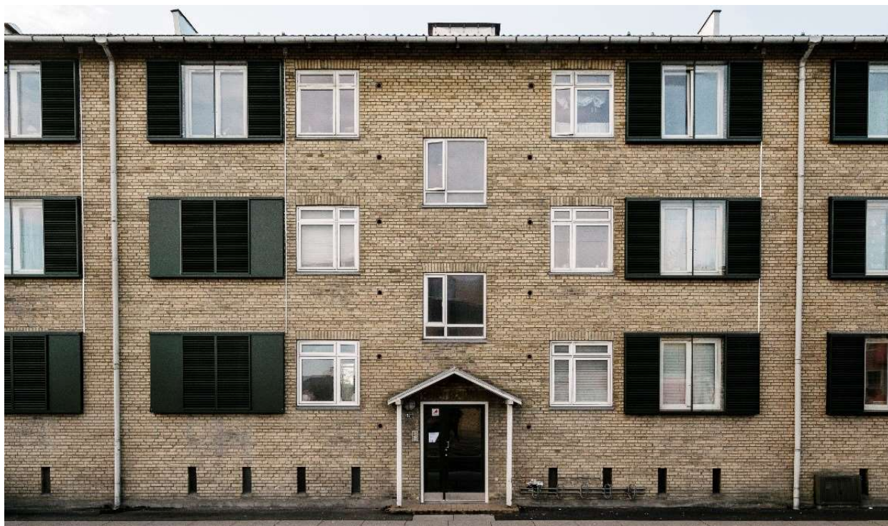
Lydskodder monteret på lejligheder i Folehaven, foto: Rambøll
