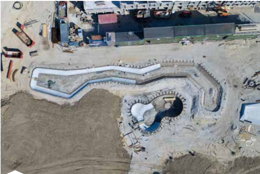
Den store klimasikring/skatepark i Høje Taastrup C håndstøbes af FSR Beton. Den åbnes senere i år. Foto: Høje Taastrup C.
