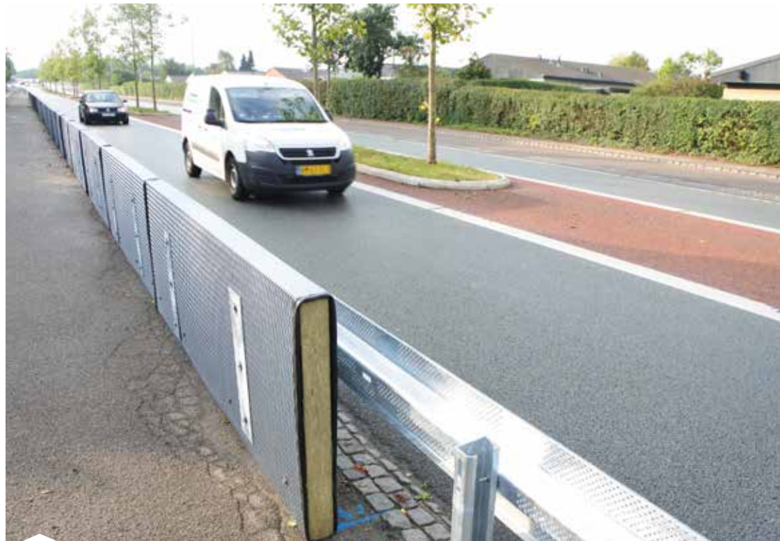
Støjabsorberende autoværn udviklet af NAG1, Silent City Living Lab på Vallensbæk Torvevej
