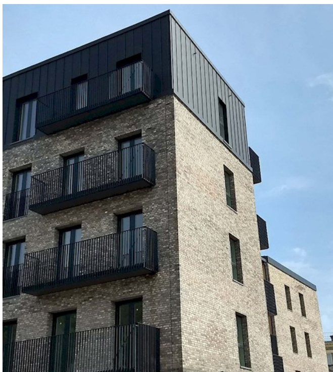
Foto af Jakobsens Hus: Gamle Mursten
