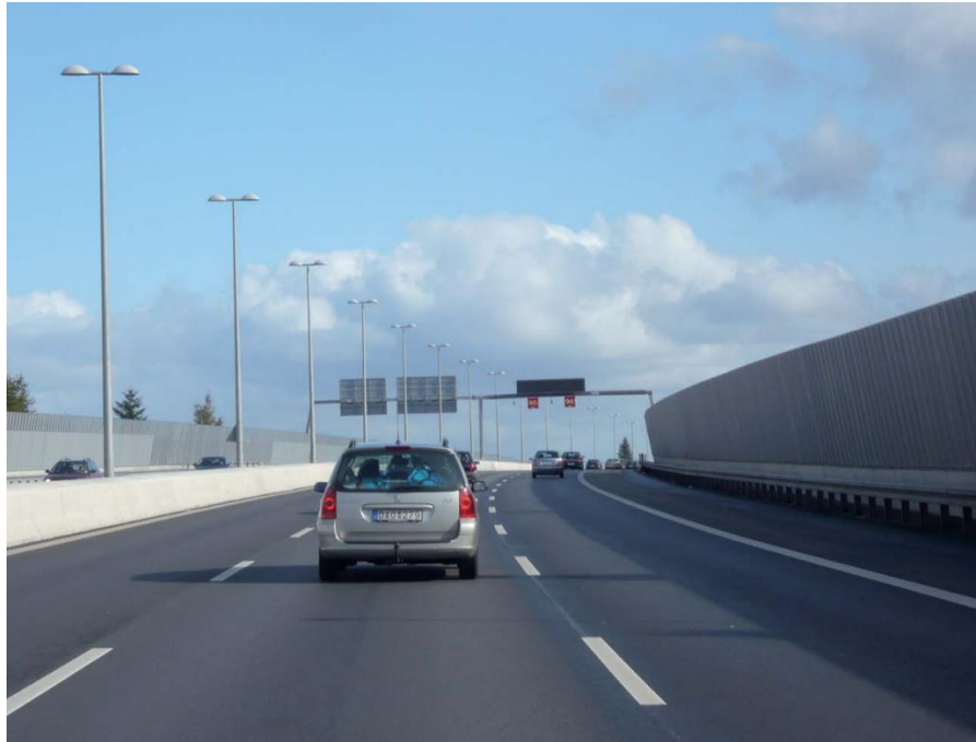
Eksempel på Motorring 3 ved København. Her er støjskærmen kippet indad mod kørebanen for at skærmtoppen kommer tættere på bilerne. Derved opnås bedre støjdæmpning. Kilde: Vejdirektoratet.
