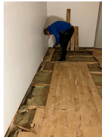
Prøveoptagning af gulvbrædder P. Olesen og Greendozer
