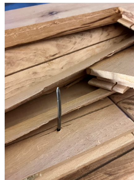
De lange søm sidder fast i feren på brædderne og skulle først fjernes
