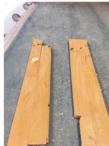
Gulvbrædder før slibning
