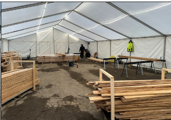
7. Nede i teltet bliver brædderne samlet og gennemgår afrensning for søm
