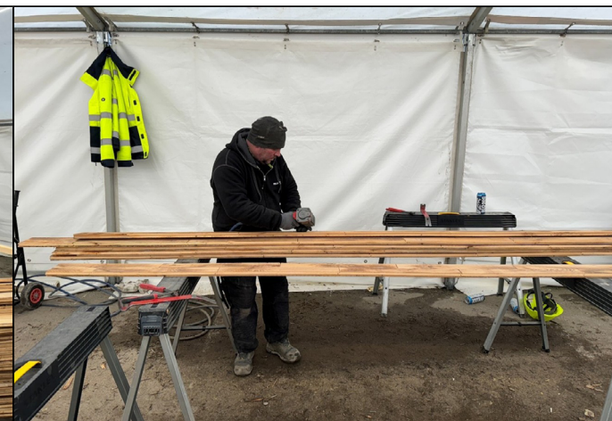
8. Sømmene skydes ud med trykluft og brættet tjekkes med metaldetektor
