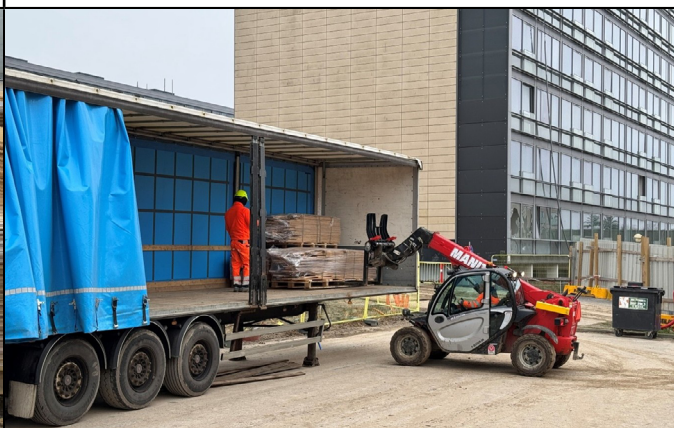
10. Når der er ca. 30 paller klar bliver de hentet af lastbilen, der kører dem til rensning for PCB eller på lager
