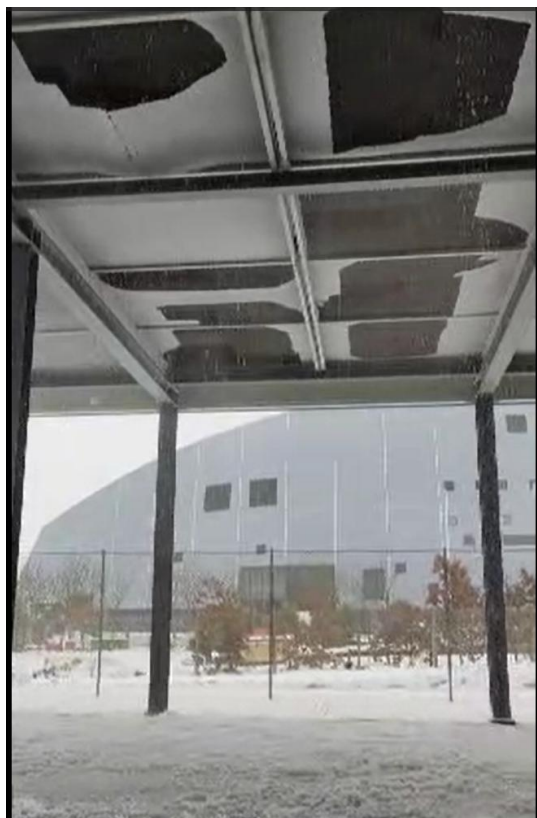
Figur 11: Undersiden af en fordampner med opadgående luftstrøm viser opbygning af isplader. Isen falder løbende ned ved hjælp af tyngdekraften.
