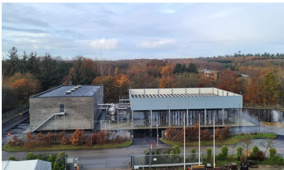
Figur 8: Kølegård med tilhørende bygning for varmepumpeanlægget. Kilde: Viborg Varme a.m.b.a., Industrivej.
