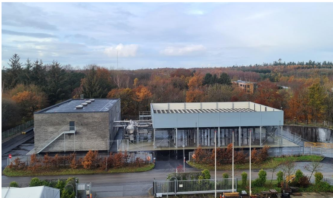
Figur 6: Luft-til-vand varmepumpe. Kølegård med tilhørende bygning for varmepumpeanlægget. Kilde: Viborg Varme a.m.b.a., Industrivej.
