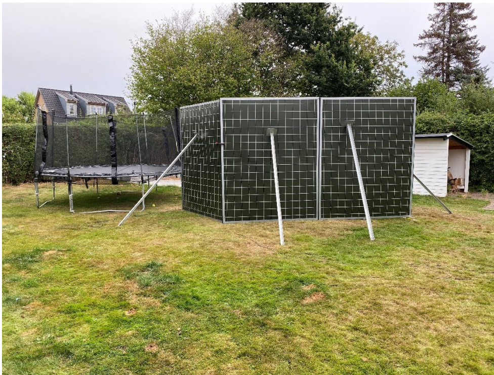
Figur 10 Bolig 1. Septembervej 126. Placering 3, højde = 2,5 m. Den hårde reflekterende side ses på billedet, den porøse absorberende side vender mod målepositionen.
