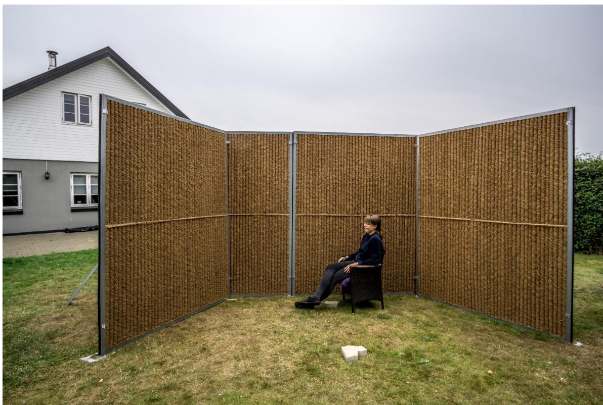
Figur 31. En støjafskærmet krog i haven. Her er anvendt et 2,5 meter højt støjhegn. Det er opstillet, så det bedst muligt afskærmer den trafikstøj, der kan komme fra forskellige retninger. I modsætning til opstillinger ved terrasser kan man ved en fri placering i haven bedre dreje opstillingen, så de åbne sider vender væk fra de retninger, hvor støjen kan komme fra. Støjhegnets virkning blev målt ved siddepladsen og ved den hvide flise i forgrunden. Der var en støjdæpende virkning på siddepladsen tættest ved støjhegnet på ca. 6 dB. 1,9 meter fra hegnet (ved den hvide flise i forgrunden) var den støjdæpende virkning ca. 3 dB. Det var i alle tilfælde den subjektive oplevelse, at hegnet medførte en mærkbar støjdæmpning, som var mest tydelig tæt på hegnet. Opstillingen er på Septembervej, placering 3 i Forces rapport.
