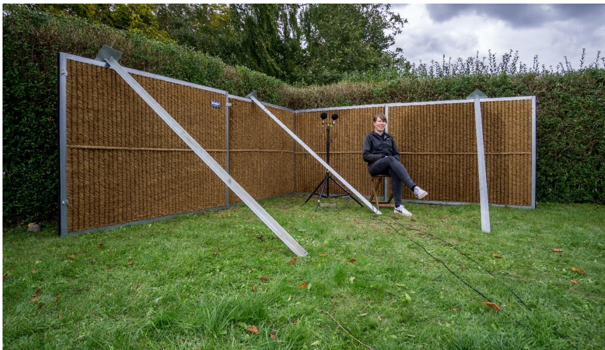
Figur 34. En krog i haven med et 1,5 meter højt støjhegn. Motorvejen ligger i billedets retning. Men der kommer også støj ind fra siderne. De to sider på opstillingen dæmper derfor støjen direkte fra motorvejen og fra den ene side, men den støj, der kommer fra højre side i billedet, dæmpes kun i nogen grad og kun, hvis man sidder tæt på hjørnet, der dannes af støjhegnets to sider. I positionen med måleudstyret blev støjen dæmpet ca. 4 dB. Det blev oplevet som en tydelig dæmpning af støjen. Opstilling på Bækkelunden, placering 1 i Forces rapport.
