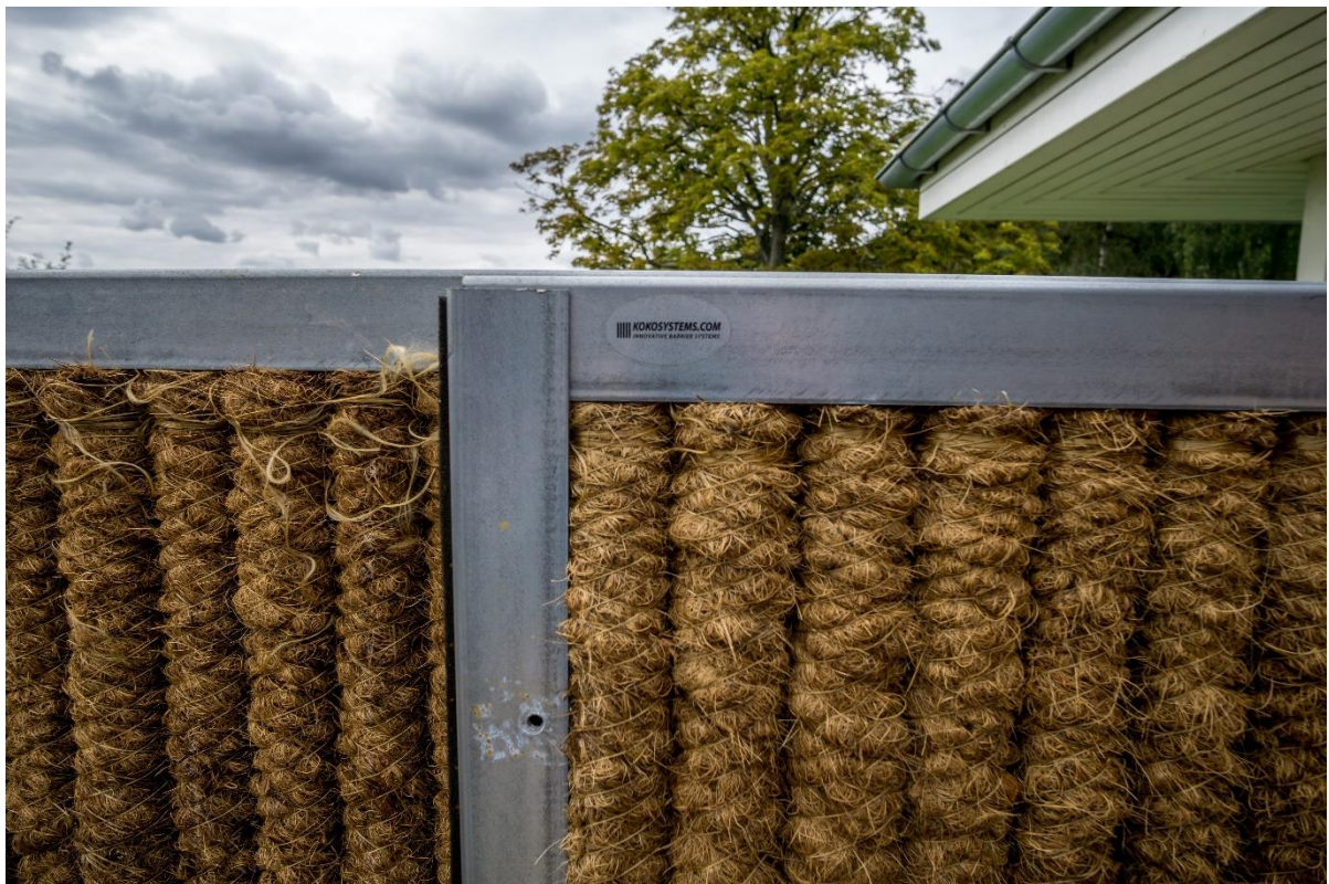
Figur 14 Den lydabsorberende side af de anvendte støjhegn. Der er anvendt rør af genbrugsplast, som er omviklet med kokosfibre. Når en lydabsorberende overflade rammes af lyd, bliver lyden ikke, eller kun i meget begrænset omfang kastet tilbage. Det kan bidrage til begrænsning af støj på en måde, der er særlig tydelig, når man er tæt på overfladen. Men det vil også bidrage til at sænke støjniveauet i et afskærmet område, f.eks. på en terrasse. Denne overflade kan også være fæste for klatreplanter.
