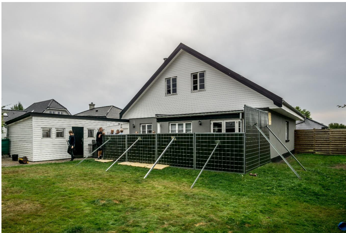
Figur 18. Opstillingen på Figur 16 med 1,5 meter højt støjhegn, set fra havesiden. Bemærk, at der blev anvendt et 2,5 meter højt element i højre side, hvor terrassen i forvejen er næsten helt lukket. Dermed lukkes de sidste åbninger i retning mod motorvejen.
