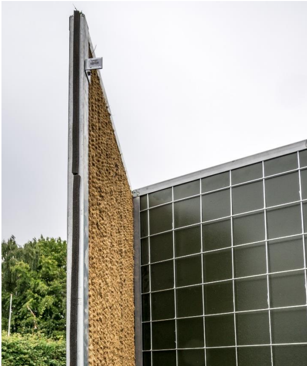
Figur 6. Støjhegnet, der blev brugt til forsøgene er af typen Ishøj Hegn 952. Det består af en ramme udført af galvaniserede stålprofiler udfyldt med en farvet stålplade på den ene side, og på den anden side rækker af rør fremstillet af genbrugsplast, der er betrukket med kokosfibre.
