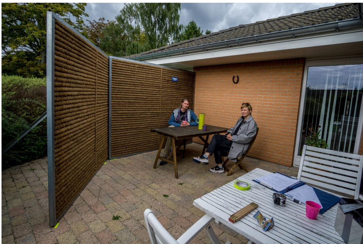
Figur 29. Denne opstilling er et 2,0 meter højt støjhegn placeret på indersiden af det bed, der afgrænser terrassen (Bækkelunden, placering 3 i Forces rapport). Det er samme terrasse som på Figur 26, Figur 27 og Figur 28, hvor hegnen er placeret på ydersiden af bedet. Fordelen ved denne opstilling er, at hegnen kommer tættere på siddepladserne, så den afskærmede krog bliver mere koncentreret. Det var den subjektive oplevelse, at støjhegnen medførte en mærkbar dæmpning af støjen. Den målte forbedring var 4 – 5 dB afhængig af siddepladsens afstand til hegnen.
