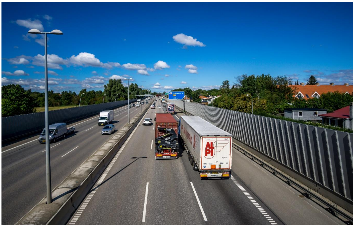
Figur 2. Det kan ved støj fra motorveje og andre store veje på nogen afstand af vejen undertiden opleves, som om støjen kommer fra alle sider. Samtidig har vejrforholdene, især vindretningen, meget stor betydning for støjen, når afstand fra vejen er 50 – 100 meter eller mere. Støjskærme lange vejen kan have god effekt ved boliger, der ligger tæt på vejen, men på større afstand kan støjskærmenes virkning være skuffende lille. Derfor er der interessant at undersøge, om der er andre muligheder, f.eks. lokale støjhegn tæt på støjens modtager – det vil sige i boligområdets haver.
