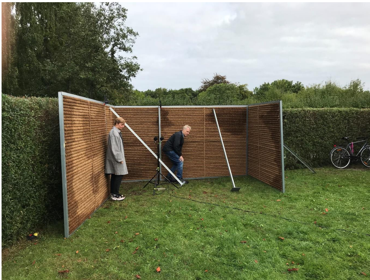
Figur 35. Samme opstilling som på Figur 34, men med et 2,0 meter højt støjhegn. Der er endvidere opstillet en vinkel, som kan dæmpe støj, der kommer fra højre side i billedet. Uden denne ekstra vinkel blev støjen dæmpet med ca. 5,5 dB. Med den ekstra vinkel opstillet var dæmpning lidt over 7 dB. Det var den subjektive oplevelse, at denne opstilling havde en god og tydeligt mærkbar virkning på den siddeplads, hvor måleudstyret står. Det illustrerer, at en optimal løsning kræver, at man får etableret afskærmning i alle de retninger, hvor støjen kommer fra.
