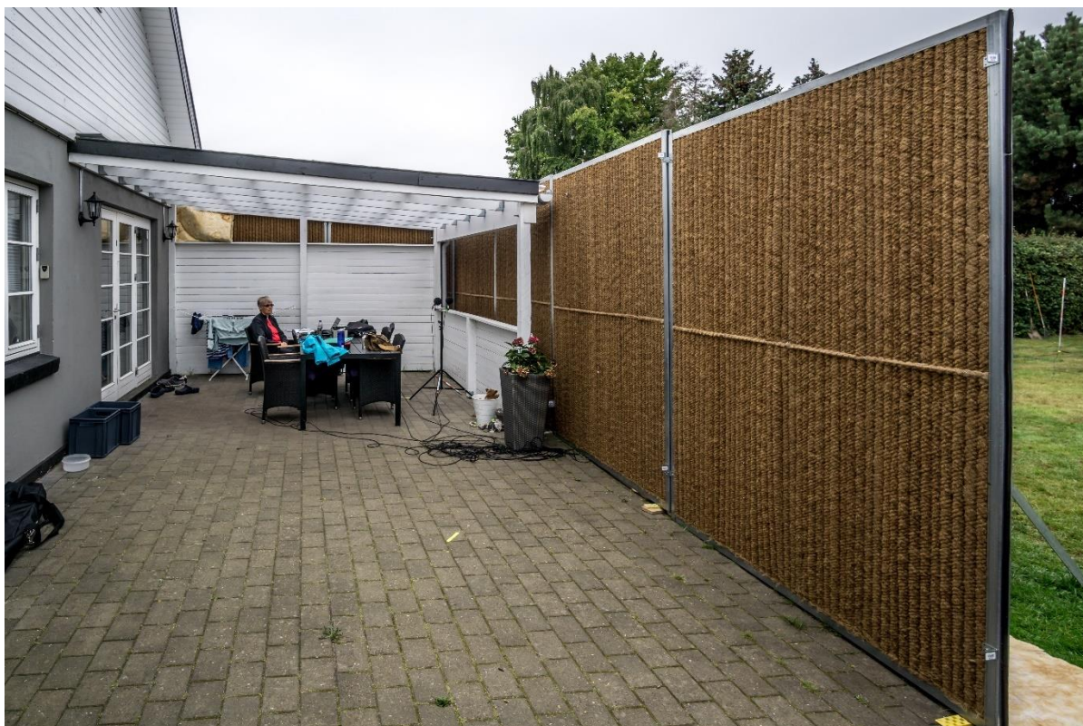
Figur 15. Den eksisterende terrasse i baggrunden (den hvide konstruktion) er delvist afskærmet og overdækket . Det opstillede støjhegn er 2,5 meter høj, hvilket skaber en helt afskærmet krog, hvor også åbninger i den eksisterende terrasse er lukket af. Det er en vigtig detalje, at støjhegnene lukker tæt mod andre bygningsdele og mod terræn. Inde ved siddepladserne medførte denne løsning en støjdæmpning på ca. 5 dB, som en er tydelig dæmpning af støjen. Den subjektive oplevelse af løsningen var også, at støjen blev dæmpet mærkbart. Opstillingen er fra Septembervej, placering 2, højde 2,5 meter i Forces rapport. På er vist samme terrasse med et lavere støjhegn. På er opstillingen vist fra havesiden. Opstillingen er fra Septembervej, placering 2, højde 2,5 meter i Forces rapport.
