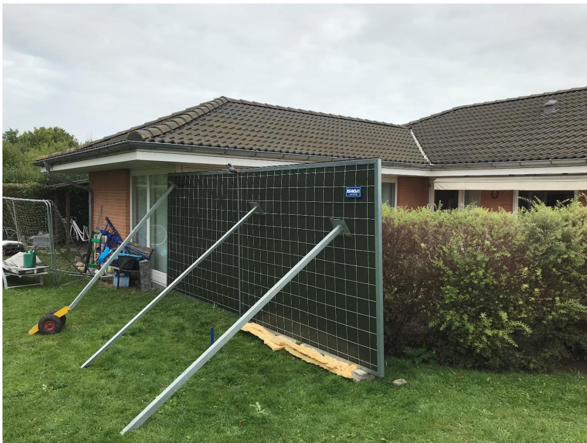
Figur 28. Opstillingen på Figur 27 med 2,0 meter højt støjhegn set fra havesiden. Trafikstøjen kommer især fra retninger bag huset, men kan også komme med ind fra venstre. Derfor er støjhegnet et godt supplement til den afskærmning, som skyldes huset. De skrå stolper er anvendt som støtte for de midlertidige løsninger, der kun skulle stå i kort tid. I en permanent løsning anvendes lodrette, nedgravede stolper.
