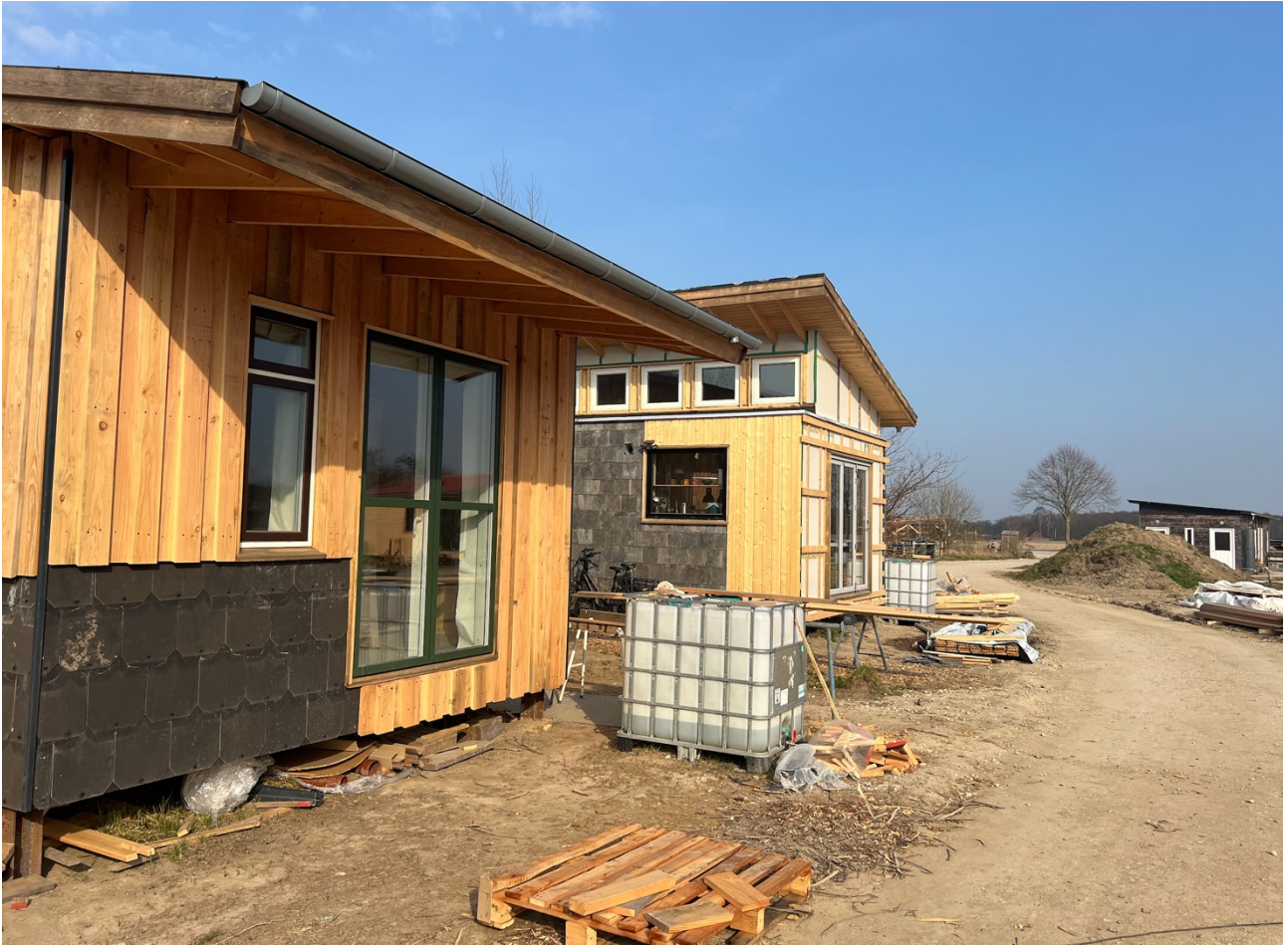
Figur 5 Hus H til venstre og hus G til højre.
