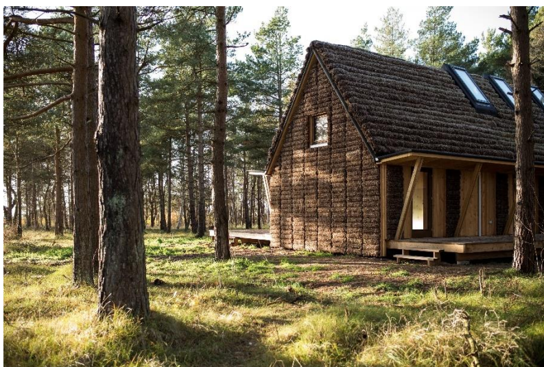
Figur 4.2. Det Moderne Tanghus med taktäckning och fasader av ålgräs på Læsø, Danmark. Bild: Helene Høyer Mikkelsen.
