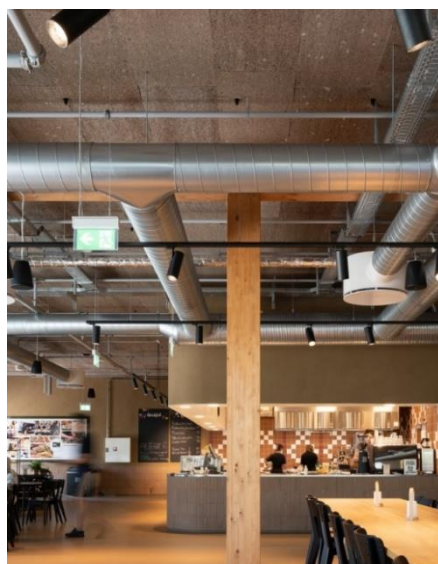
Figur 4.4. Søulds Acoustic Mat FR installeret hos IKEA i København. Foto: Søuld
