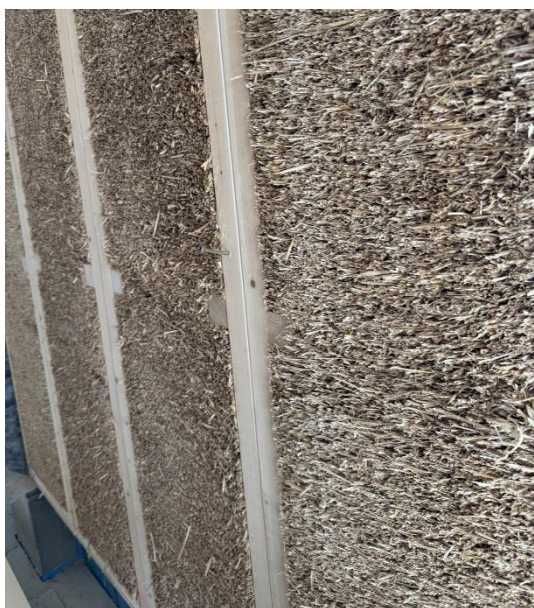
Figur 4.5. Halmbalselement som utfackningsvägg, ETC höghus i Malmö. Foto: P.B. Strandberg-de Bruijn
