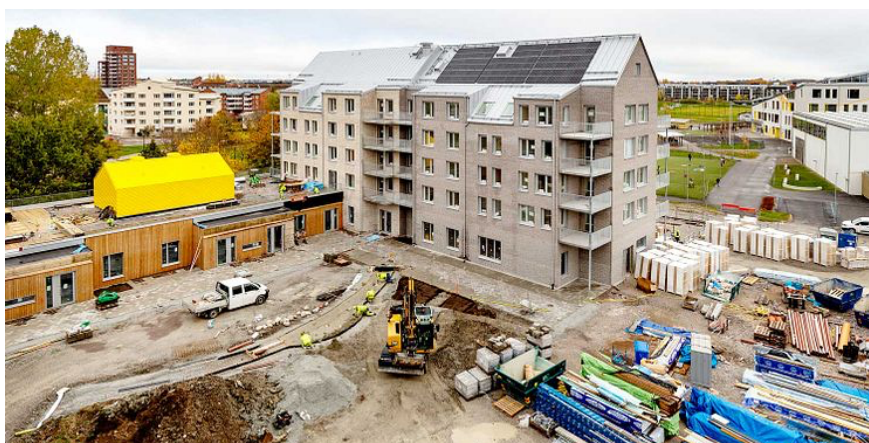
Det nye kvarter Tamarinden opføres i Örebro som et energifællesskab.
