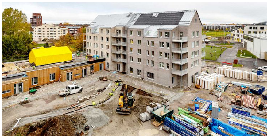
Det nya kvarteret Tamarinden byggs i Örebro som en energigemenskap.
