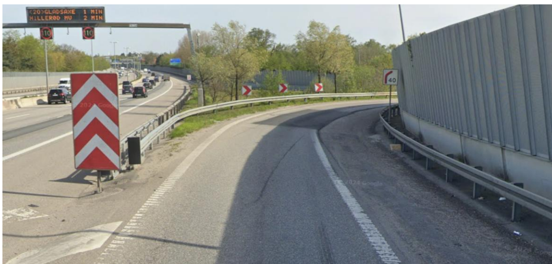
Figur 26. På frakørselsrampen TSA 21 Herlev på Motorring 3 i nordgående køreretning er der denne skarpe kurve, hvor anbefalet hastighed er angivet ved start af kurve.
